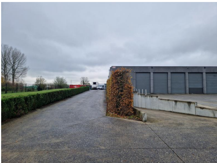
Kaart 13: Oprit en toegangsweg met een duidelijk aflopend profiel richting straatzijde, zonder vlakke zone voor waterbuffering.
