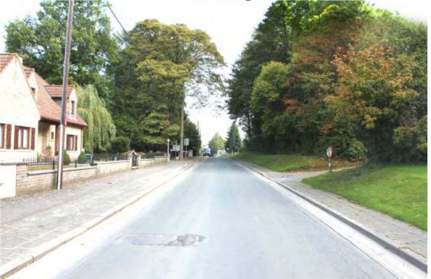
d'Arconatistraat na kruispunt Kasteelstraat: bestaande situatie
