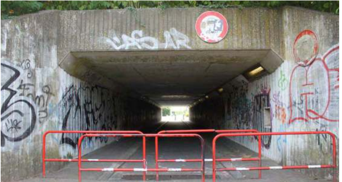
De tunnel onder de N8: bestaande situatie
