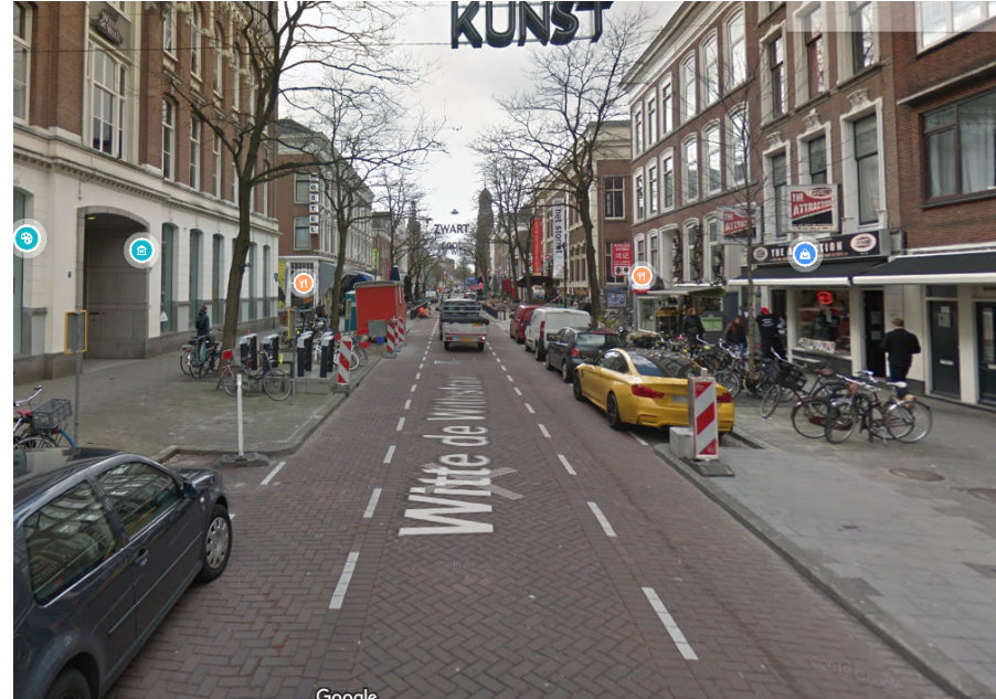
Figuur 38 – voorbeelden van inrichting van straten met 'print' voor gemotoriseerd verkeer (trilling ondersteunt tragere snelheid) en idealiter een zeer effen rode asfaltverharding voor die fietser die het comfort verhoogt. Kan zowel in de stad op een enkelrichtingstraat (rechts) als in een dorpsomgeving in een dubbelrichtingstraat (links)
