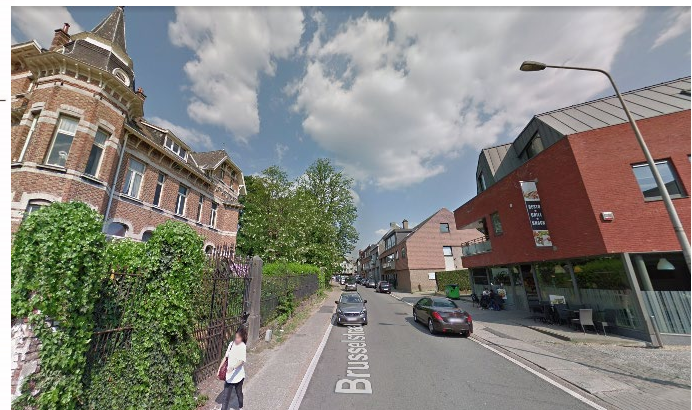
Figuur 12 - foto Brusselstraat (Google Streetview)
