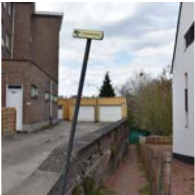
1. Afwerking hoogteverschil ter hoogte van de Itterbeeksebaan
