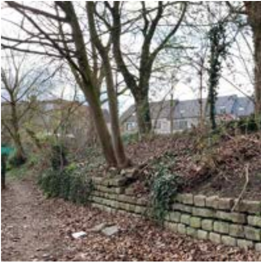
4. Restanten muur steilrand
