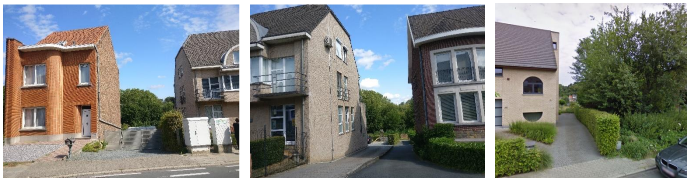
Bebouwing langs de Itterbeeksebaan (3) (4) (5)
