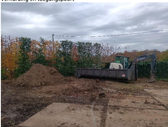
Zone met ondergrondse pijpleiding
