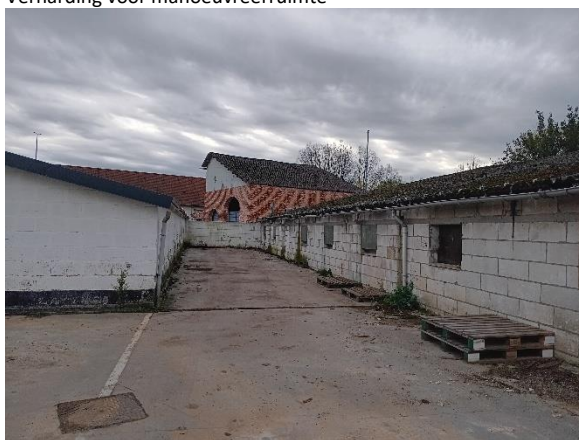
Ruimte tussen twee bestaande loodsen
