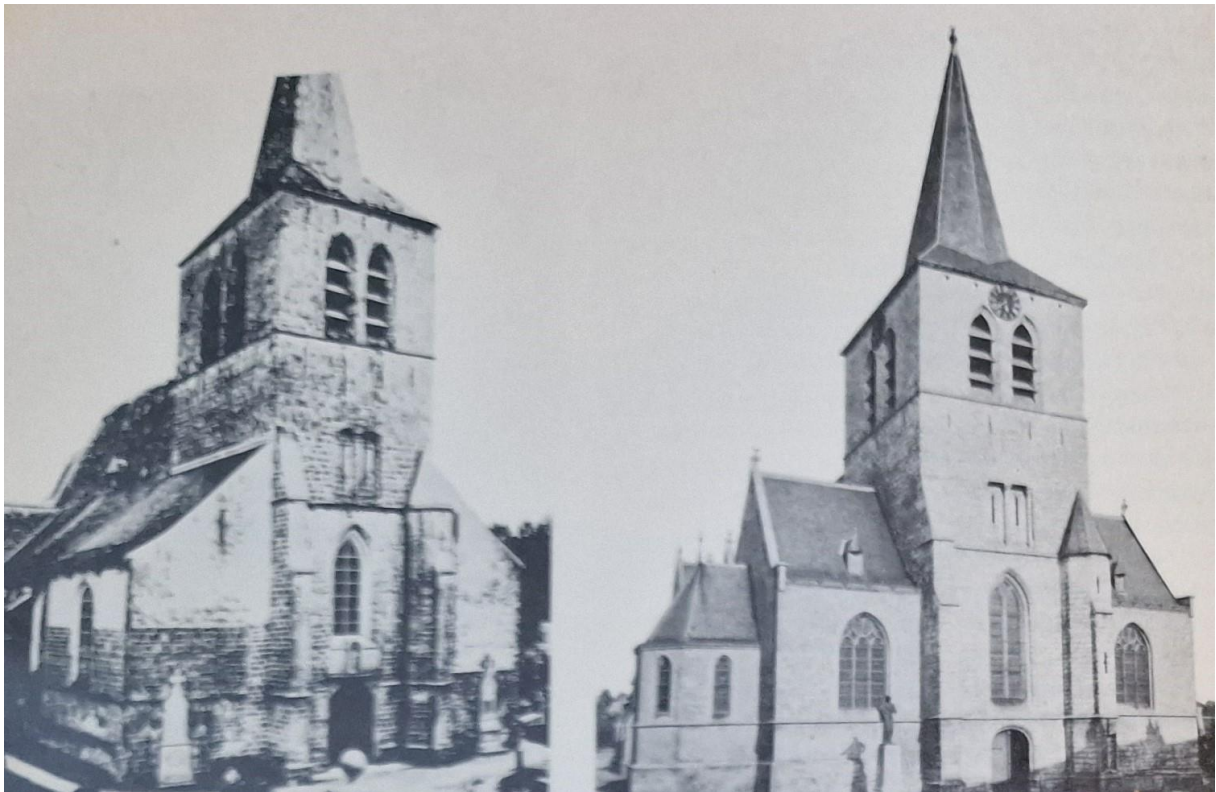
Figuur 65 De westgevel voor en na de renovatie van 1908-1912.
